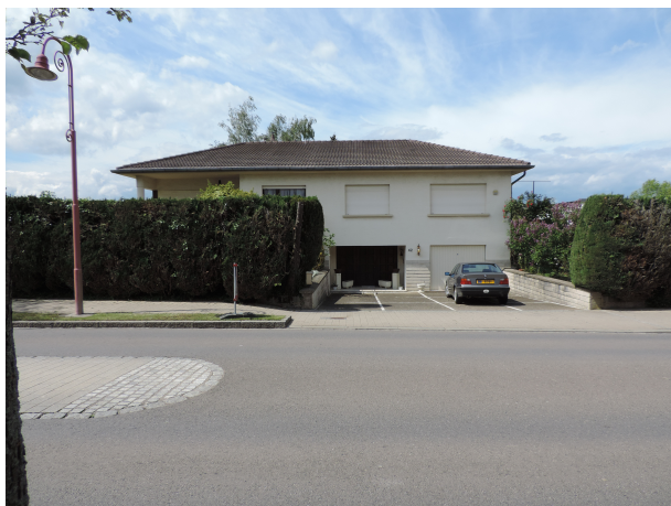
maison existante « n°42, route de Mondorf » (bâtiment à démolir)
