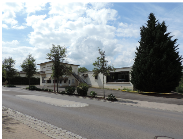
garage existant « n°40, route de Mondorf » (bâtiment à démolir)
