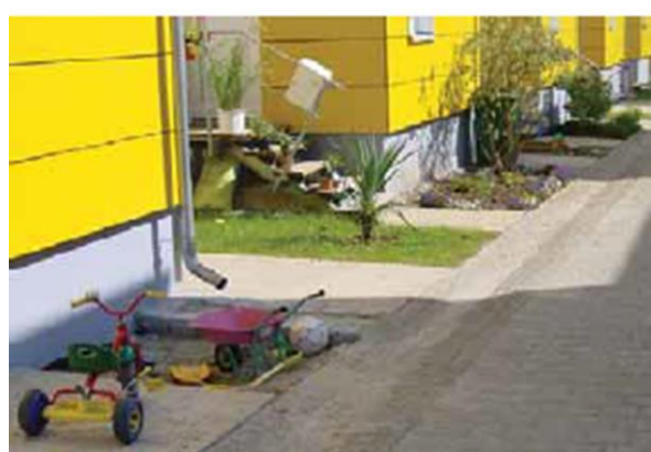
Figure 21 : exemples d'aménagement (voirie et descente de toit) pour les eaux pluviales
