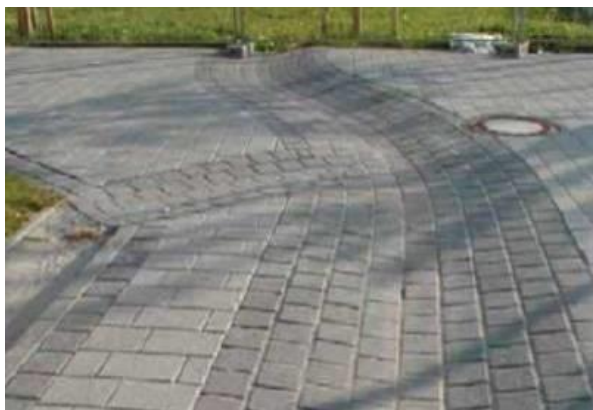
Figure 21 : exemples d'aménagement (voirie et descente de toit) pour les eaux pluviales
