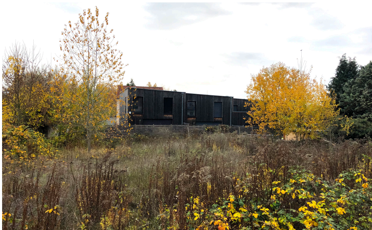
Figure 6: Vue à l'arrière du site 2019
