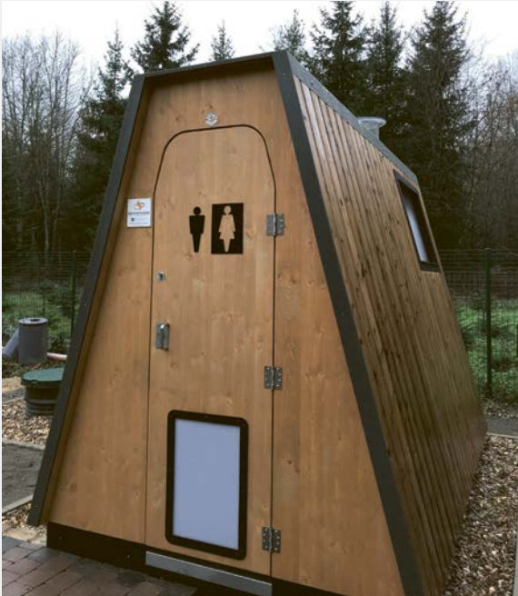
Neue Komposttoilette für die Stadt Remich / Nouvelle toilette à compost pour la Ville de Remich
