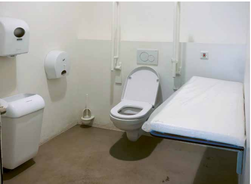
Anbringen eines aufklappbaren Wickeltisches geeignet für PEM in den öffentlichen Toiletten im Centre visit Remich/ Installation d’une banquette rabattable murale pour PMR dans les toilettes publiques au Centre visit Remich
