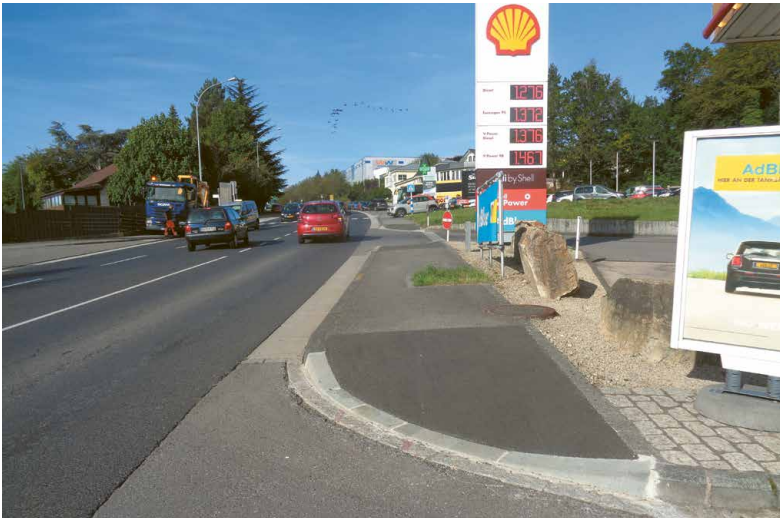
Erneuerung des Bürgersteigs in der Route de l’Europe / Adaptation du trottoir dans la route de l’Europe
