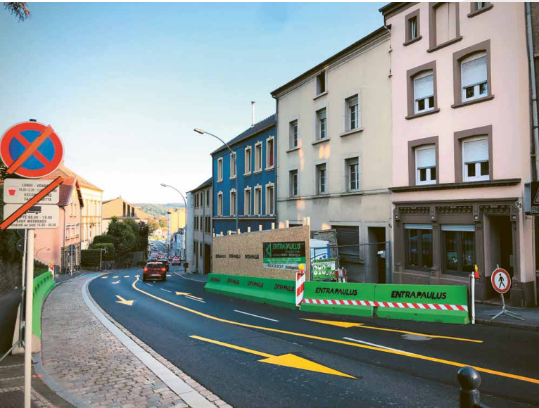
Baustelle Rue Enz bis vorraussichtlich Ende Februar 2022 / Chantier rue Enz prévisiblement jusque fin février 2022
