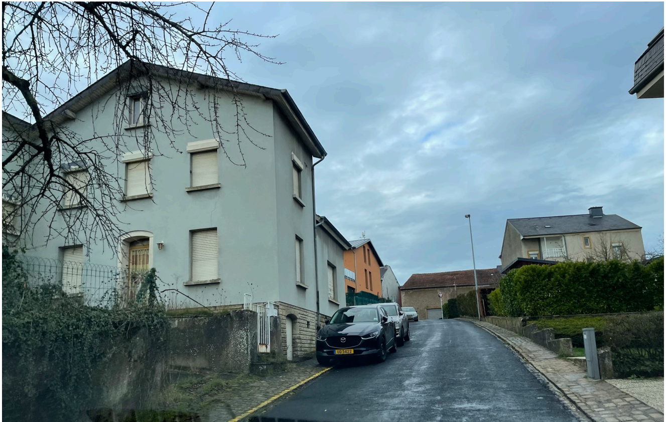
Foto 1: Blick auf das Bestandsgebäude an der Route de Mondorf
