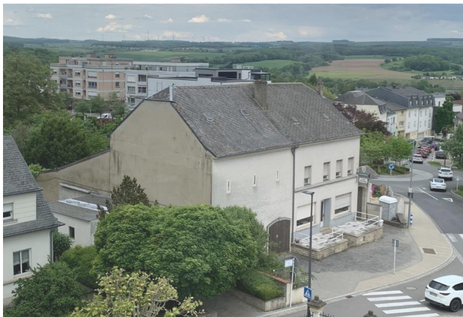
Photo 5 : Vues du bâtiment existant (Source : BEST)
