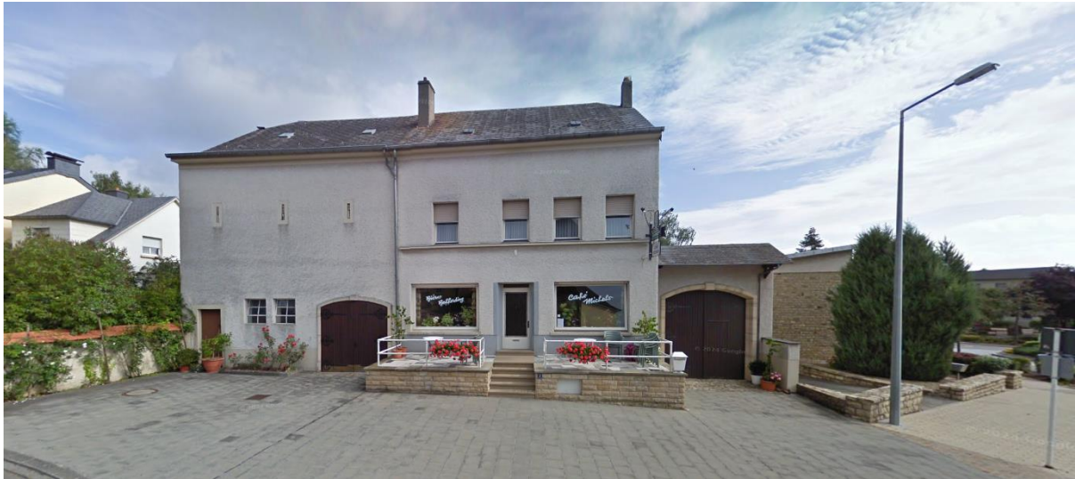
Photo 1 : Vue du bâtiment existant (Source : Googlemaps, 2024)
